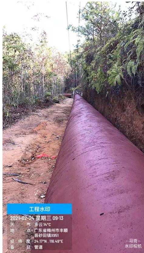
附图 13 岳坑一级电站压力管道
