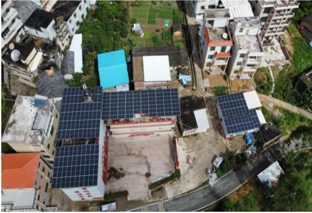
图2-3 龙岗镇马图村光伏发电项目
